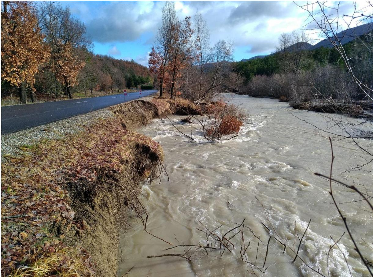
**Figure 3: Erosion des berges de la Méouge emportant l'accotement de la RD (Salérans, décembre 2019)**
